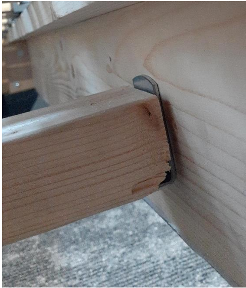
La barre latérale (barre jaune) repose « dans » l'équerre.
